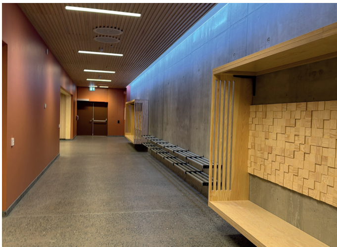
Store deler av underetasjen er i plasstøpt betong.
